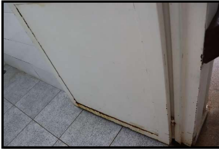
Porta do banheiro do quarto da enfermaria. Fonte: Acervo MNPCT, 2024.
