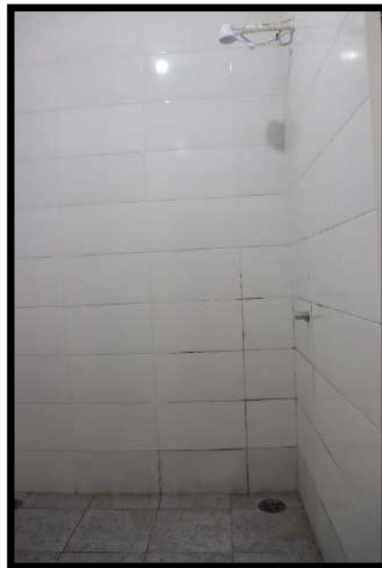
Banheiro do quarto da enfermaria. Fonte: Acervo MNPCT, 2024.
