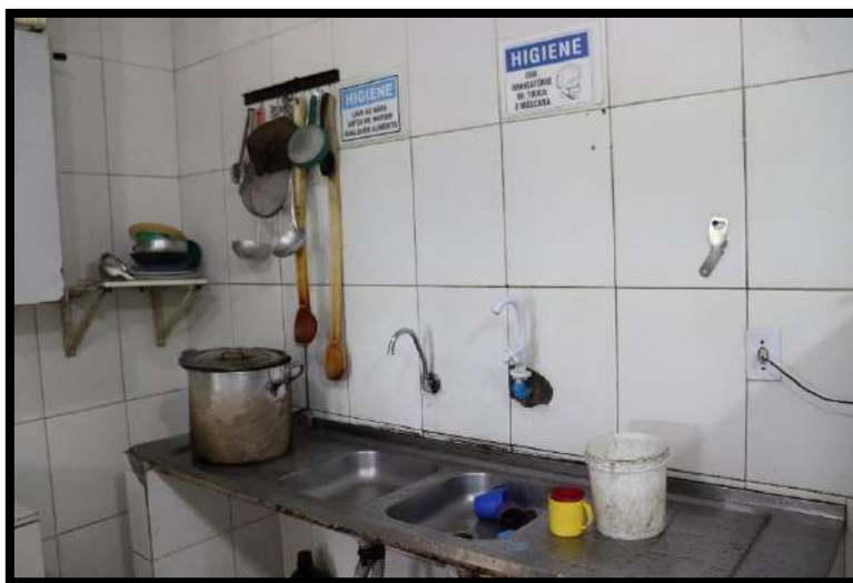
Torneiras sem sistema de filtragem. Fonte: Acervo MNPCT, 2024.
