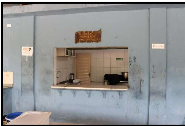
Acesso à cozinha pelo refeitório.
