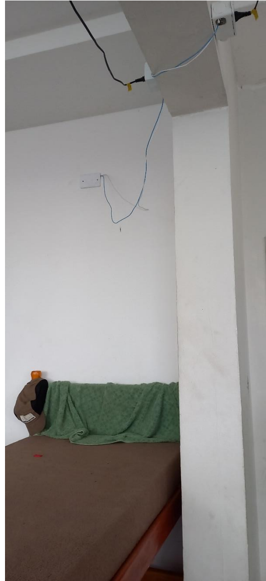
Vedação da parede de dormitório por tapume e fiação exposta próxima ao leito de cima dos beliches.
