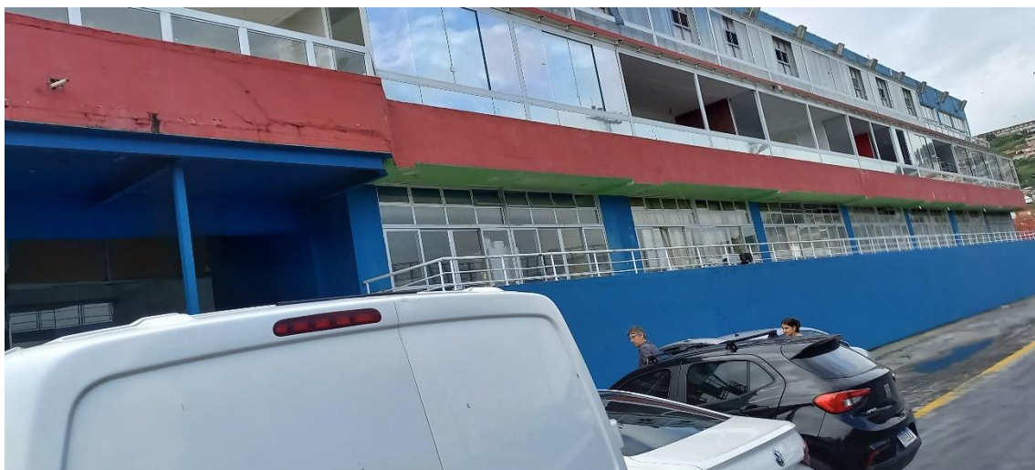
Fachada da Passarela da Cidadania. Os camarotes para assistir às escolas de samba do estado são transformados em dormitórios. Nos andares superiores, por trás dos vidros, há paredes de tapumes, para fácil remoção.
