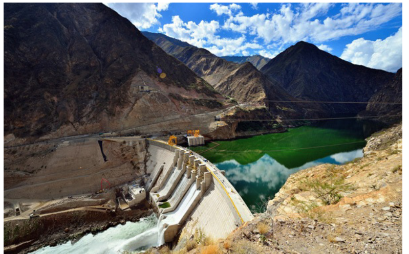
Centrale Idroelettrica - Perù
