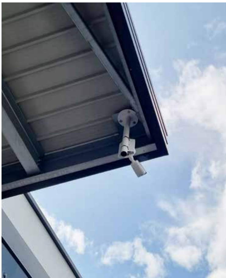
Palo Monaco60 H 500 mm bianco - installazione a soffitto con base PF0060FB - staffa bianca per telecamera AM2957FB
