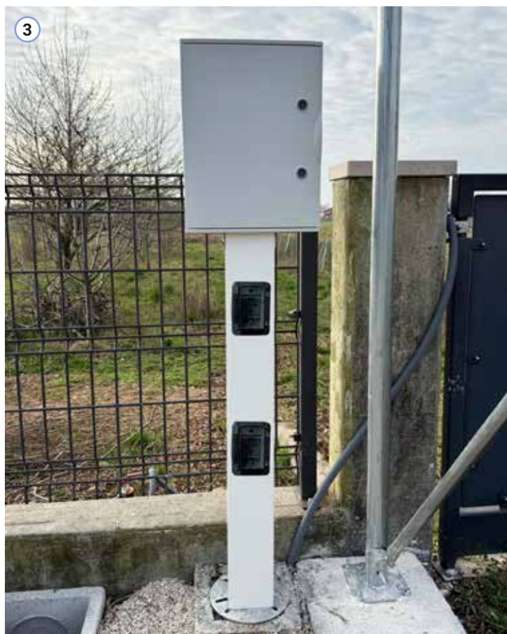
Palo Boston120 H 1000 mm bianco - installazione a pavimento con base CQBL25FZ + staffe di supporto testa palo CQA052FZ + 2 fori 3 moduli CRF003FN
