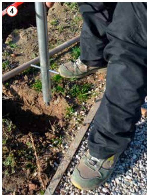
Composizione prodotto: piantone PT1500FZ + supporto a regolazione orbitale PU1812FZ
