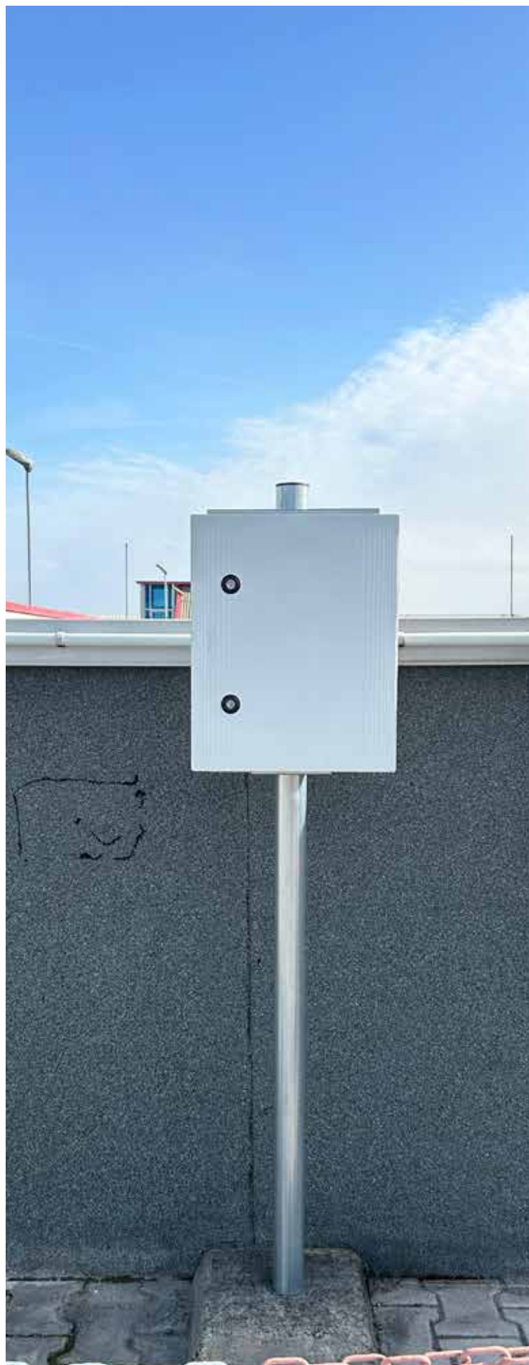
Palo Monaco60 H 1500 mm zincatura da nastro - incastrato: incassato in fondazione di calcestruzzo + staffe di supporto quadro AD1040FZ + tappo ABS nero AP0260PN
