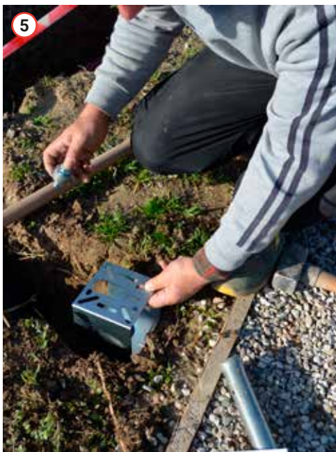
Composizione prodotto: piantone PT1500FZ + supporto a regolazione orbitale PU1812FZ
