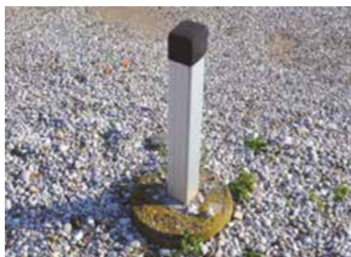
Realizzazione standard: installazione a terra in cemento
