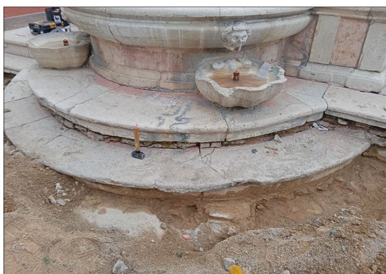
Fontana della Fortuna, durante il restauro. (Foto di Roberta Martufi)
