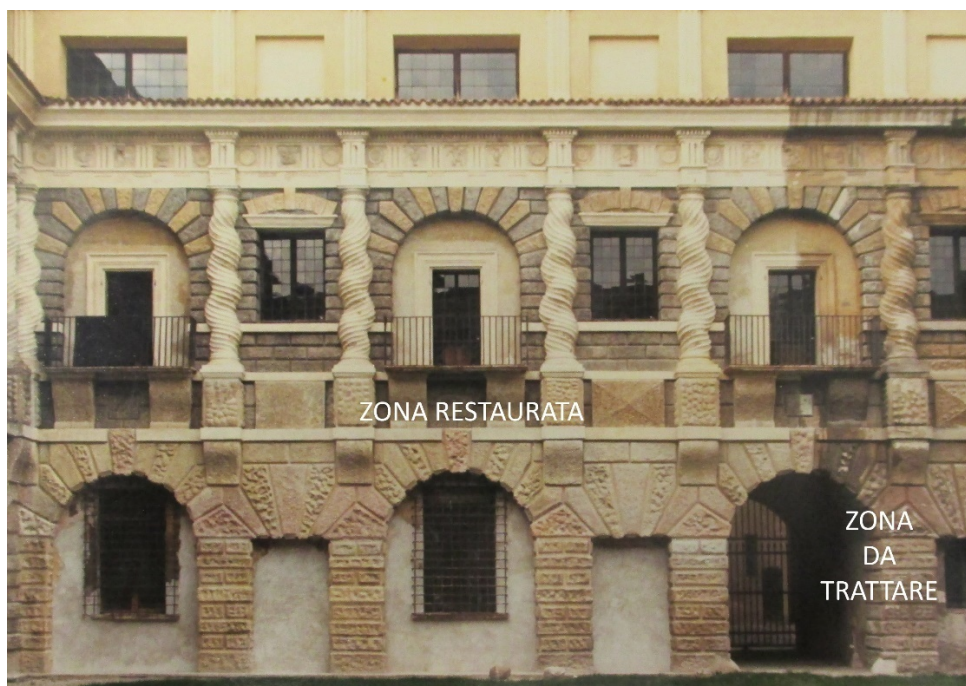
Cortile della Cavallerizza, Fronte Mostra, individuazione dell’area restaurata
