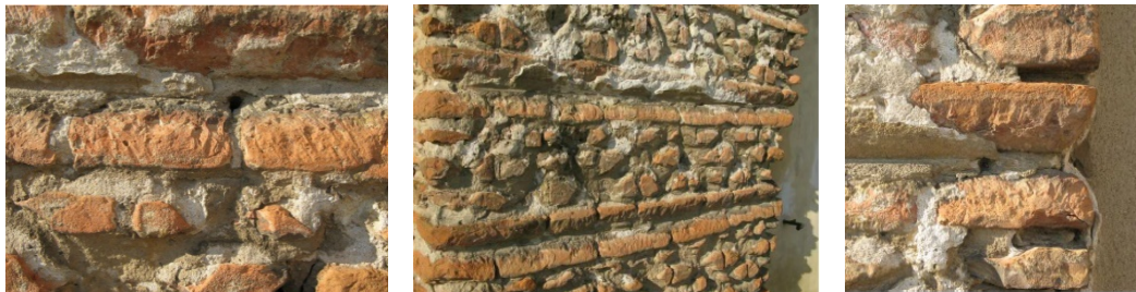
Esempi di murature costituenti il supporto dei bugnati nel Cortile della Cavallerizza
