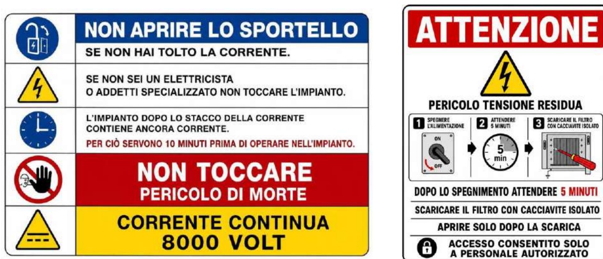
Fig. 16 – Etichette per la sezione elettrostatica: divieto di apertura sotto tensione e procedura di scarica della tensione residua.
