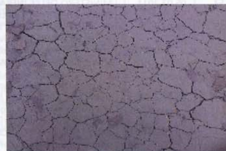
Tipica fessurazione da ritiro in terreni argillosi
