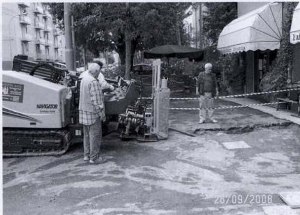
Figura 10 – Realizzazione delle perforazioni “No Dig”
